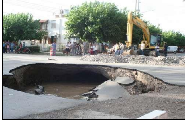
Figura Nº 6. Colapso de cloaca al este de Santa Lucía.
