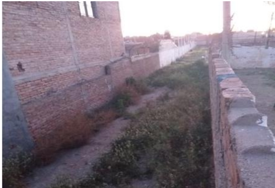
Imagen 7; Pasillo o pasaje colindante a la tribuna Sur
