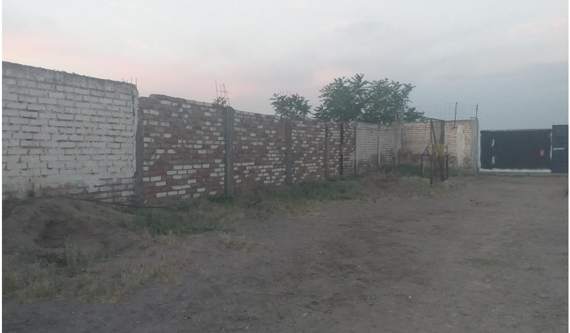
Imagen 12; Pared perimetral Noroeste (ingreso público visitante)
