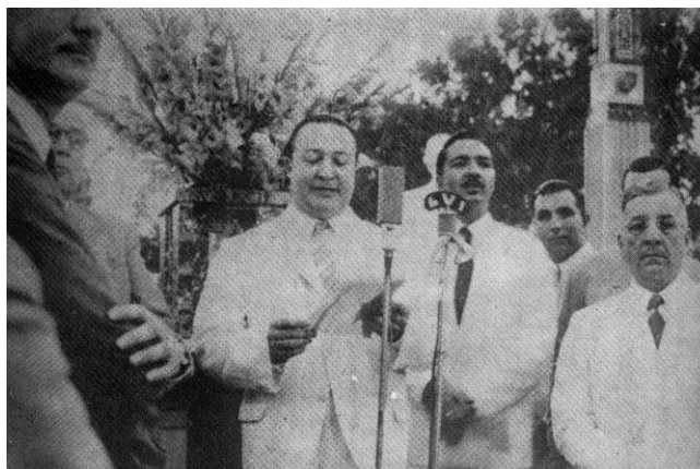
Inauguración de la antena de 216 metros en LV1, 20 de diciembre de 1942. Fuente: 80 años de vida industrial, p.19
