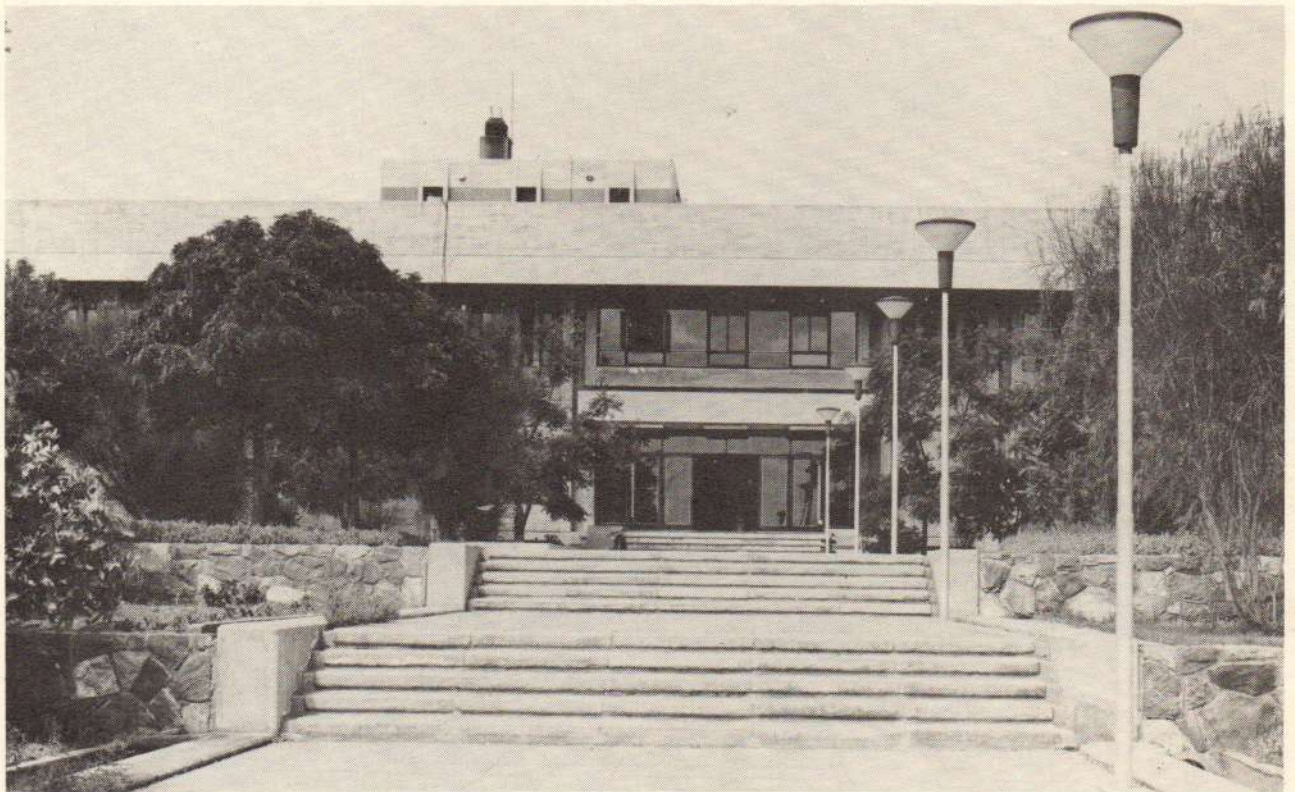
ACCESO PRINCIPAL AL EDIFICIO DE DOCENCIA Y ADMINISTRACION.
