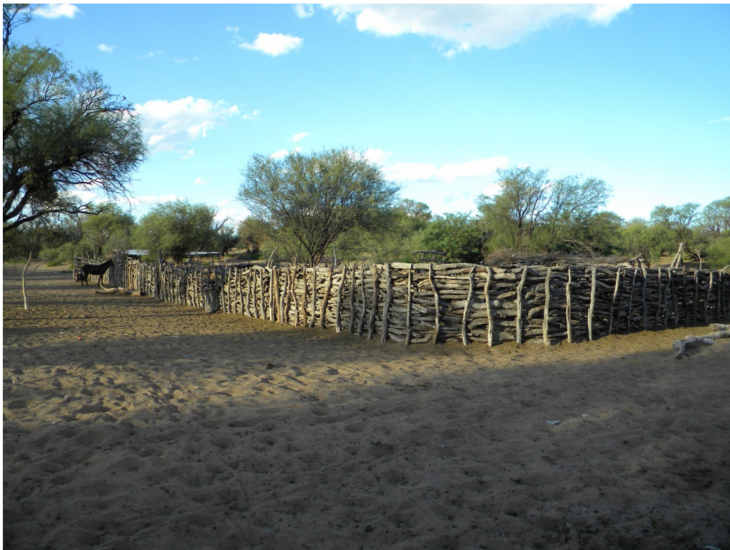
Figura 1.7. Fotografía tomada en un puesto donde se aprecia un corral construido con ramas y troncos de P. flexuosa . Foto Cecilia Vega Riveros
