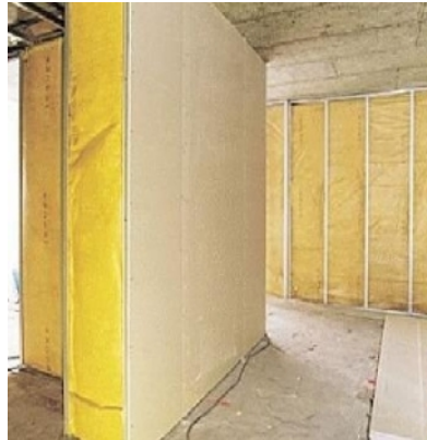
Figura 9 - Detalle de cerramientos interiores
