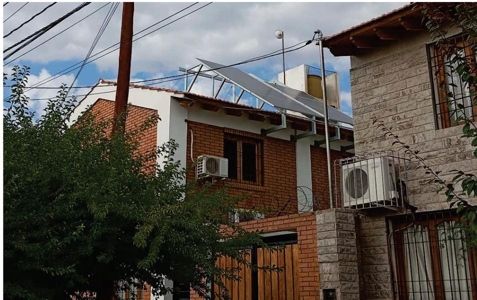
*Figura 6. Paneles solares instalados sobre la oficina.*
