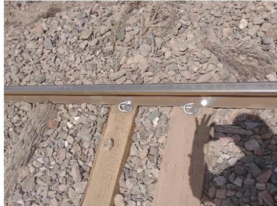
Ilustración 5 Retiro y colocación de durmientes. Ilustración 6. Replazo de durmiente y fijación elástica
