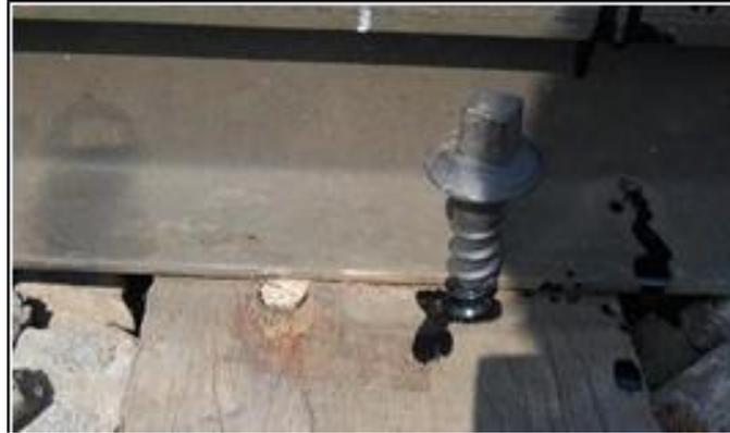
*Ilustración 8. Fijación rígida, tirafondos A0.*
