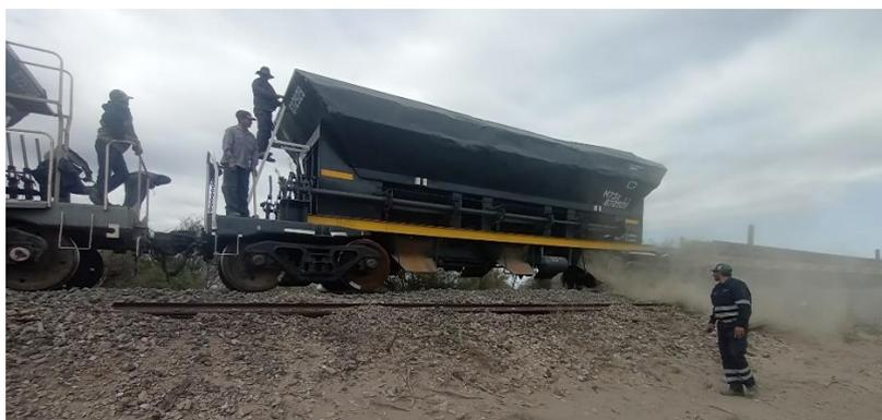
*Ilustración 25. Descarga o balasteo de la piedra en sector designado.*
