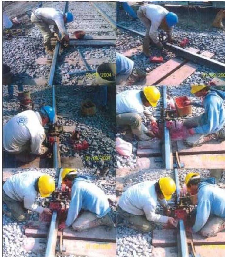
*Ilustración 23. Procedimiento del preparado previo de Soldadura.*
