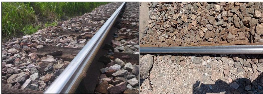
*Ilustración 17 y 18. Rieles con desgaste lateral interior y exterior de riel invertido.*
