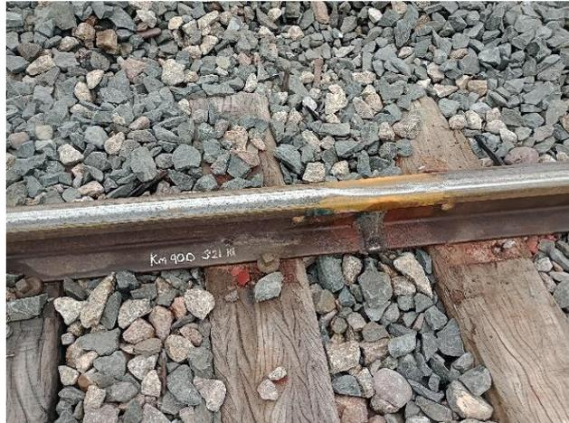
Ilustración 22. Soldadura terminada.
