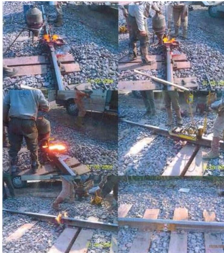
*Ilustración 24. Procedimiento de Soldadura.*
