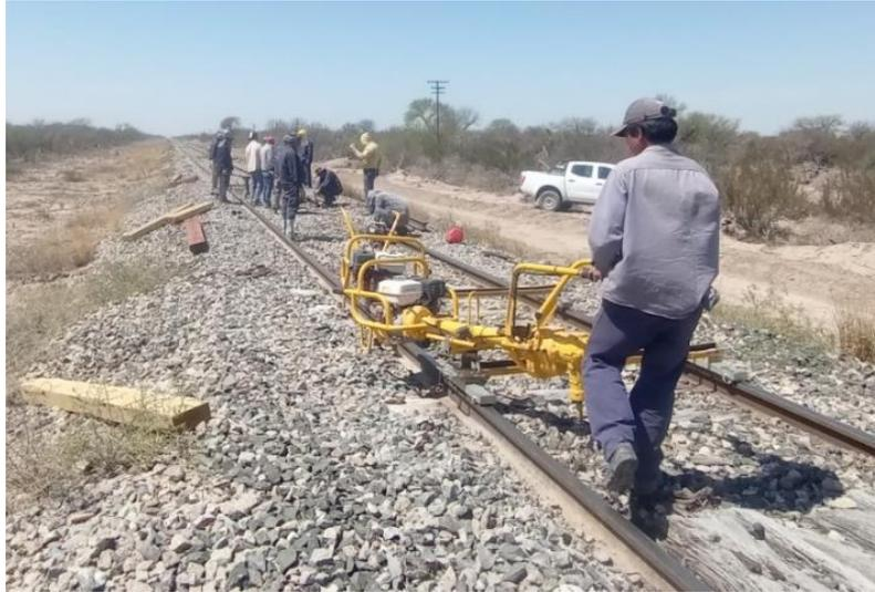
*Ilustración 7. Método de refijado de tirafondos A0.*
