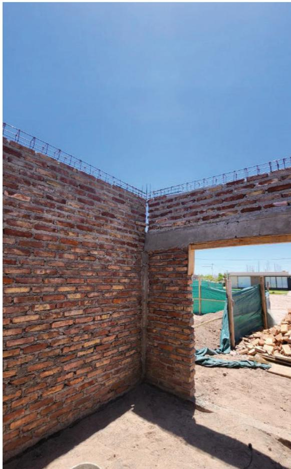
Figura 15: Armado vigas de techo
