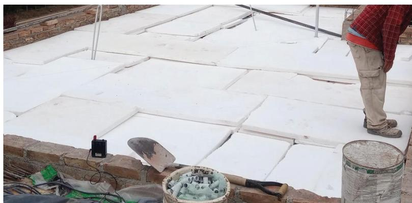
Figura 21: Colocación de poliestireno expandido
