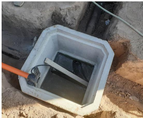
Figura 33: Cojinete cámara de inspección
