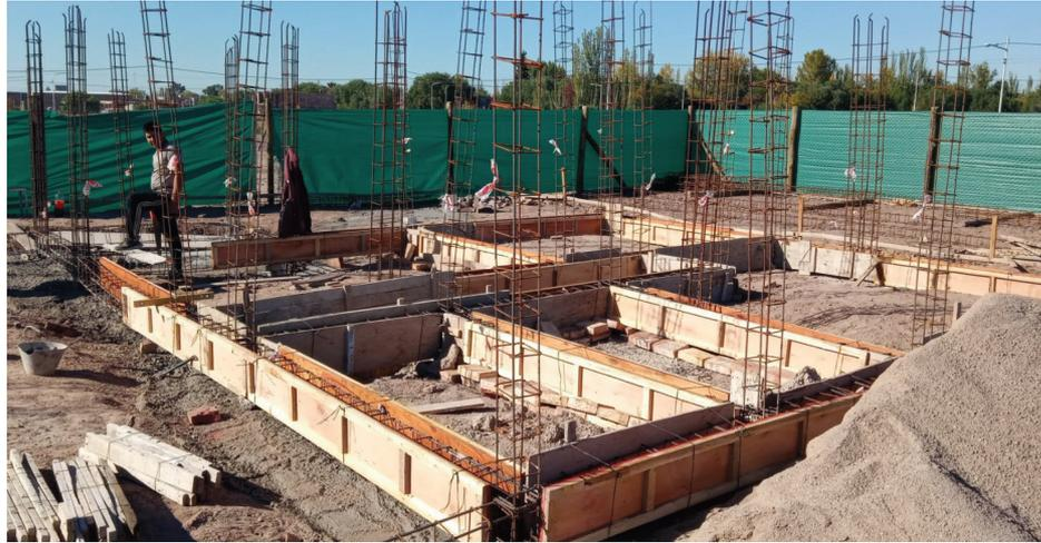
Figura 9: Encofrado de vigas de fundación
