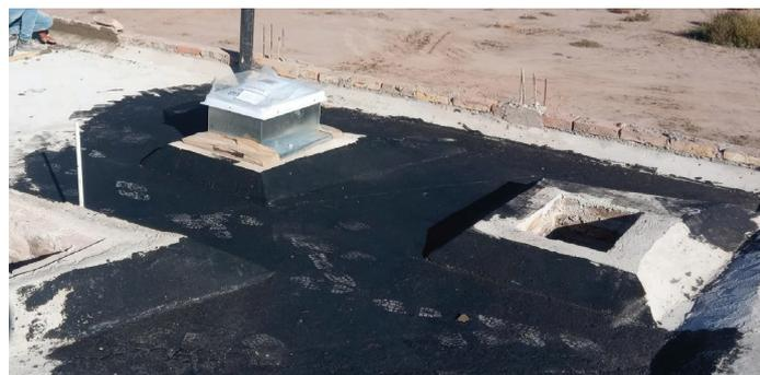
Figura 24: Pintura asfáltica
