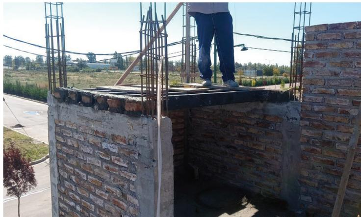
Figura 17: Encarozado y colocación de vigas de tanque
