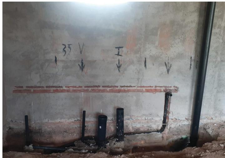
Figura 30: Instalación desagüe en baño y ventilación
