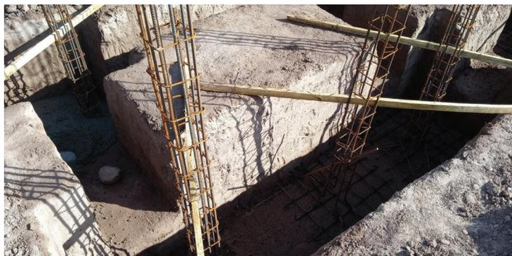
Figura 6: parrillas de bases sobre hormigón de limpieza
