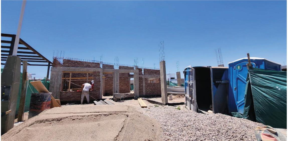
Figura 16: Vigas de techo listas para encofrar y continuación de columnas.
