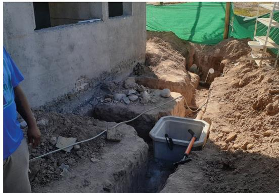
Figura 32: Cámara de inspección
