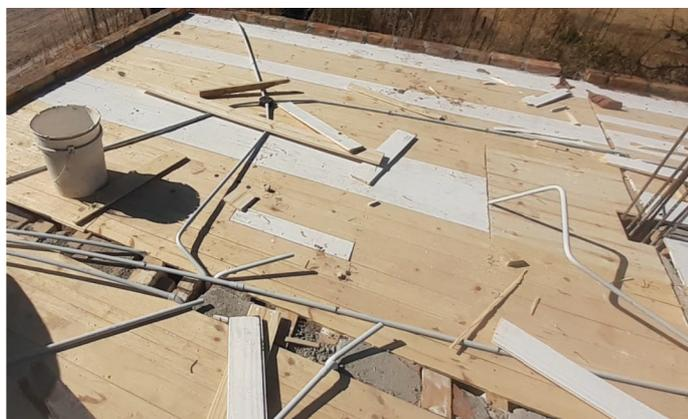
Figura 26: "Araña eléctrica" en cubierta
