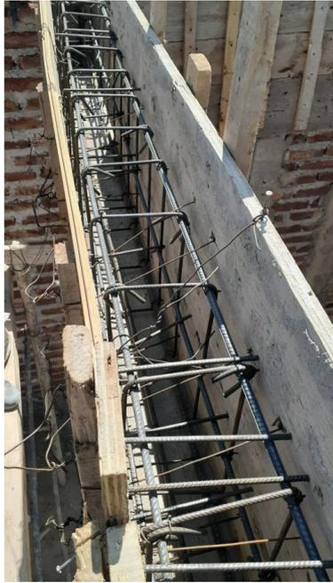
Figura 14: Viga de techo
