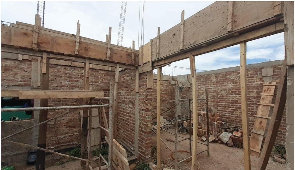
Figura 13: Encofrado de vigas
