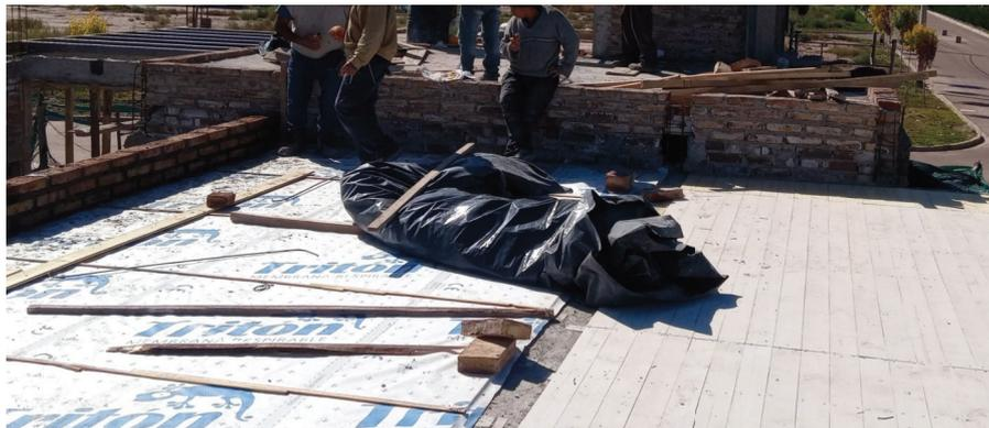
Figura 20: Colocación de machimbre y barrera de vapor
