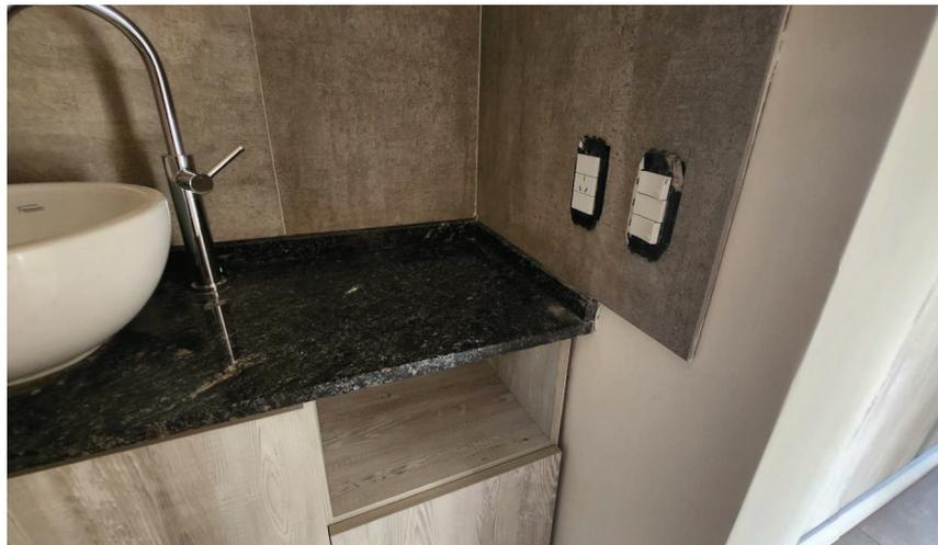
Figura 37: Falta de tapa de bastidores
