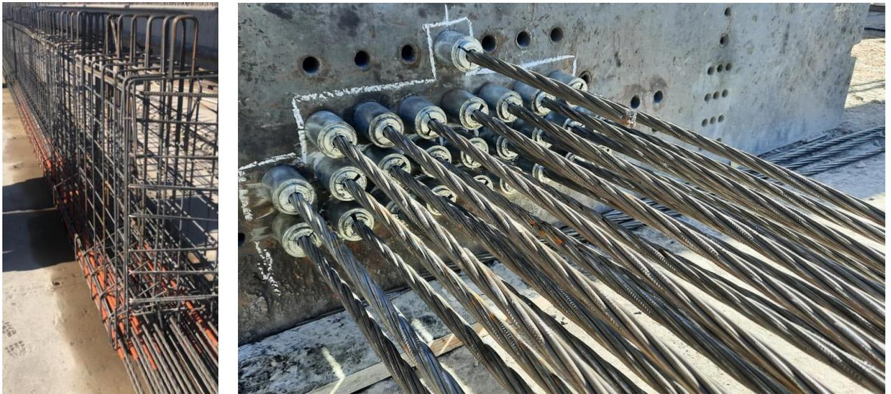
Ilustración 9: Armadura de vigas pretensadas
