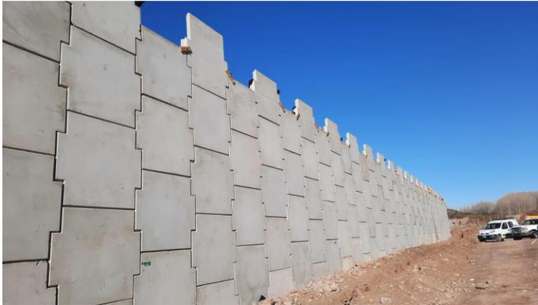
Ilustración 31: Muro 11 de tierra armada
