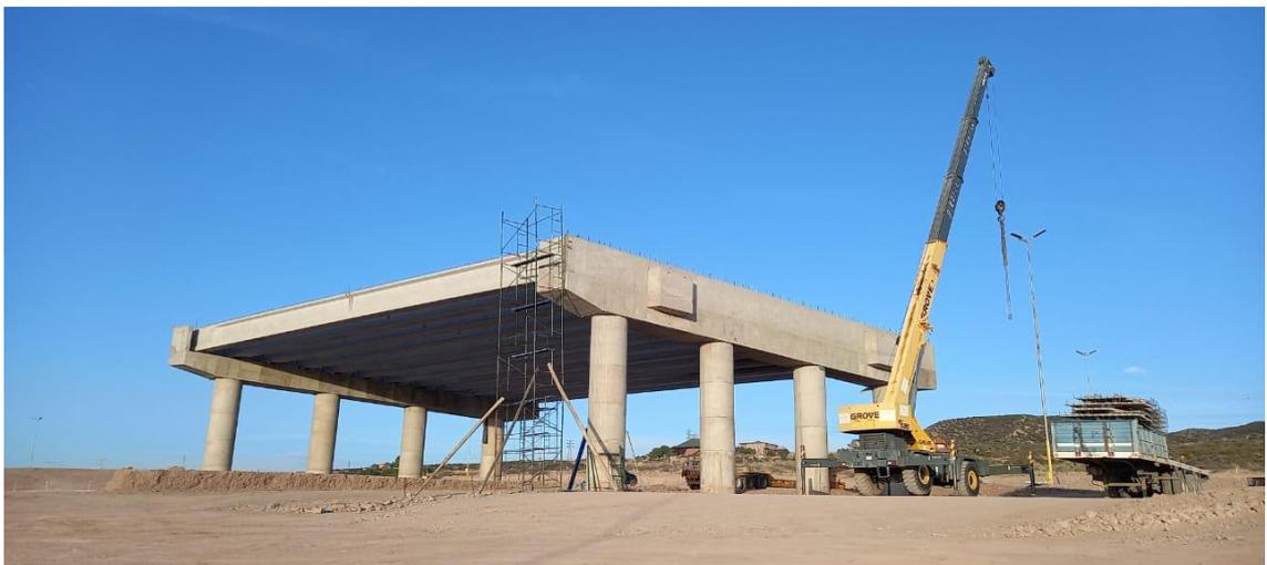
Ilustración 16: Vigas principales montadas
