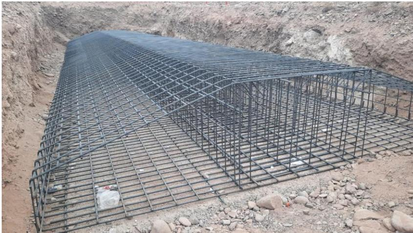
Ilustración 6: Armadura de fundación de estribo sur
