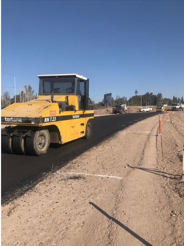
Ilustración 52: Rodillo neumático
