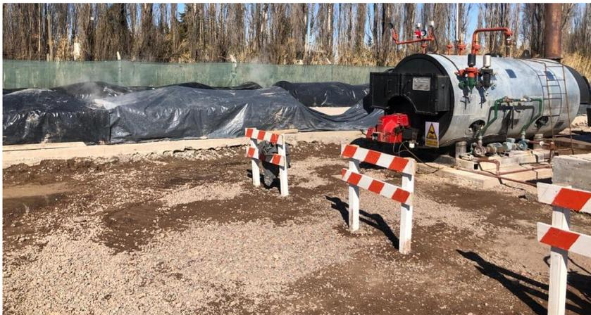
Ilustración 34: Sistema de calefacción para colado de hormigón en invierno
