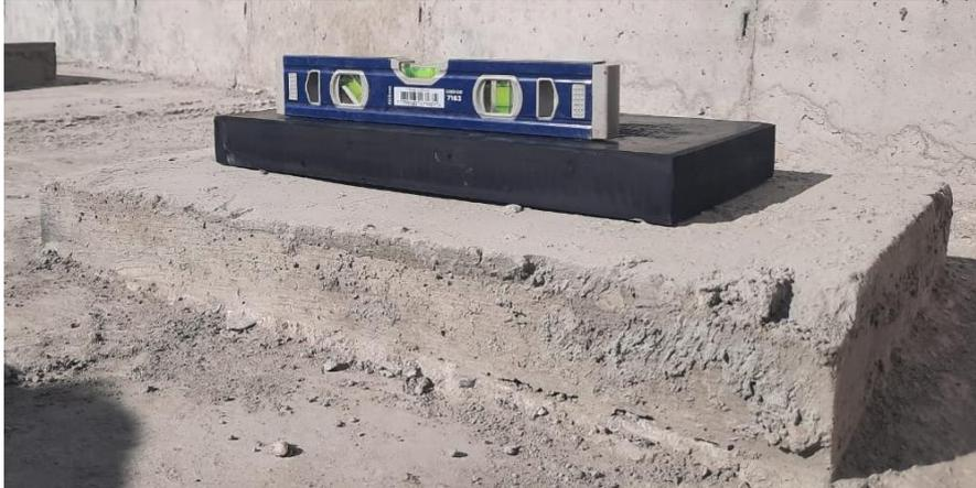
Ilustración 13: Apoyo antisísmico
