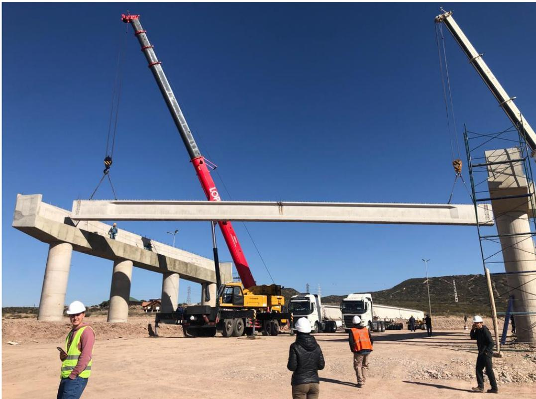
Ilustración 14: Traslado y montaje de vigas del Puente 2
