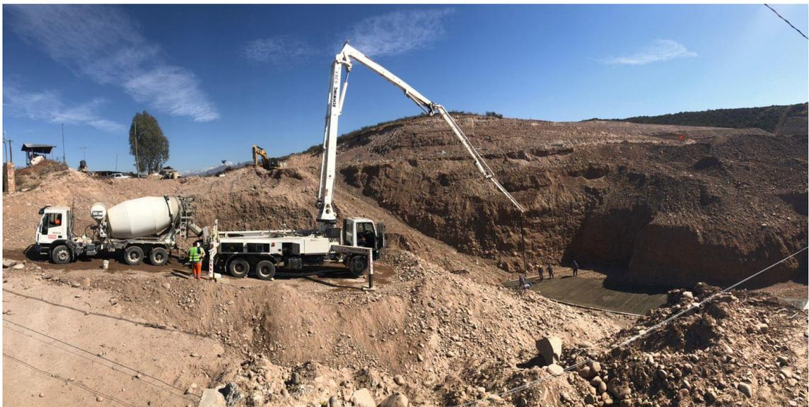
Ilustración 26: Fundación estribo norte "Puente Besares"
