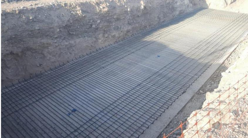
Ilustración 5: Hormigón de limpieza
