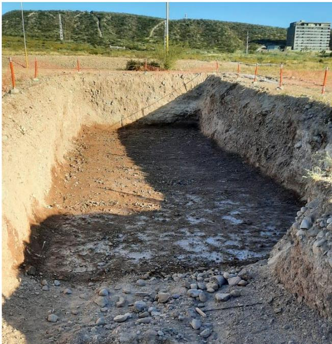
Ilustración 4: Excavación para fundación de estribo sur
