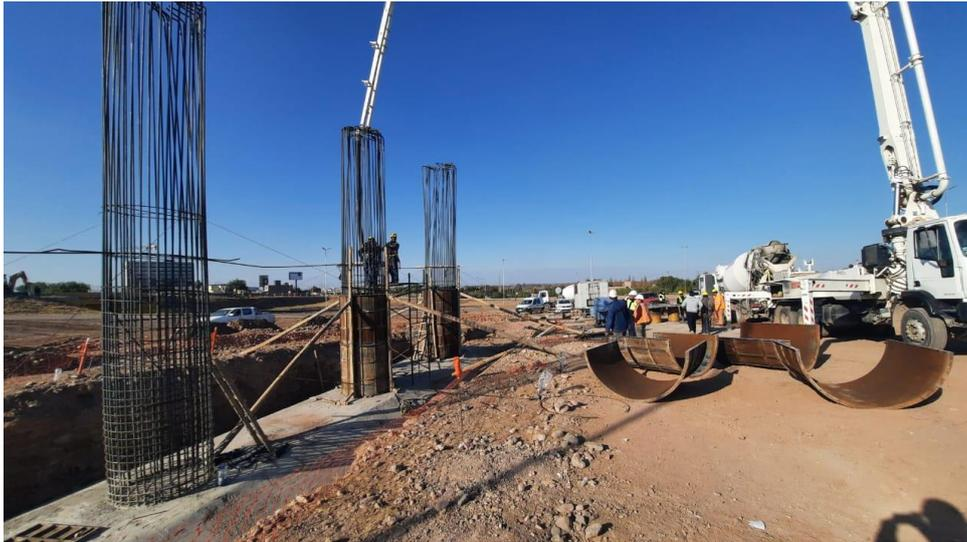
Ilustración 11: Armadura y llenado de columnas
