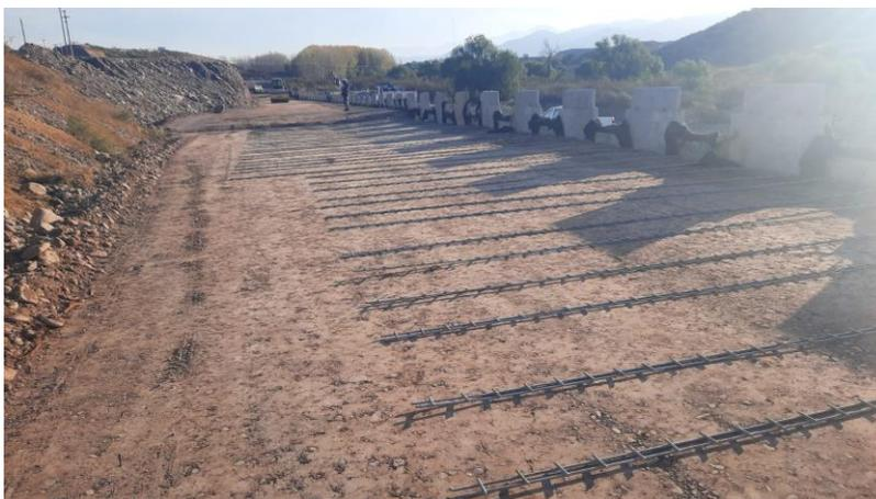
Ilustración 32: Colocación de flejes metálicos
