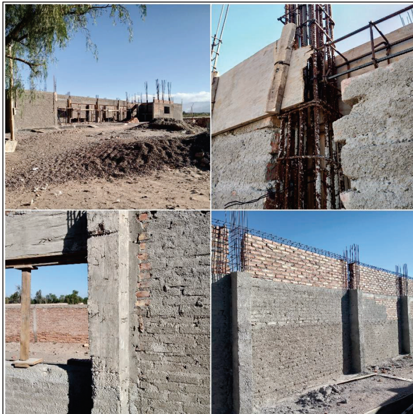
Figura 8: Visita a obra del 25/4/2022 – Avances en muros sobre encadenado.
