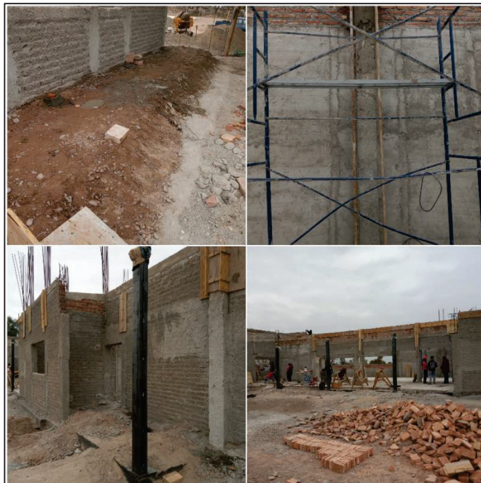
Figura 14: Visita del 24/6/2022 – Rectificación de columnas y revoques.
