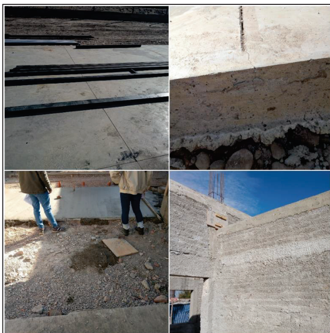
Figura 11: Visita del 30/5/2022 – Comenzado el armado de vigas de cubierta.
