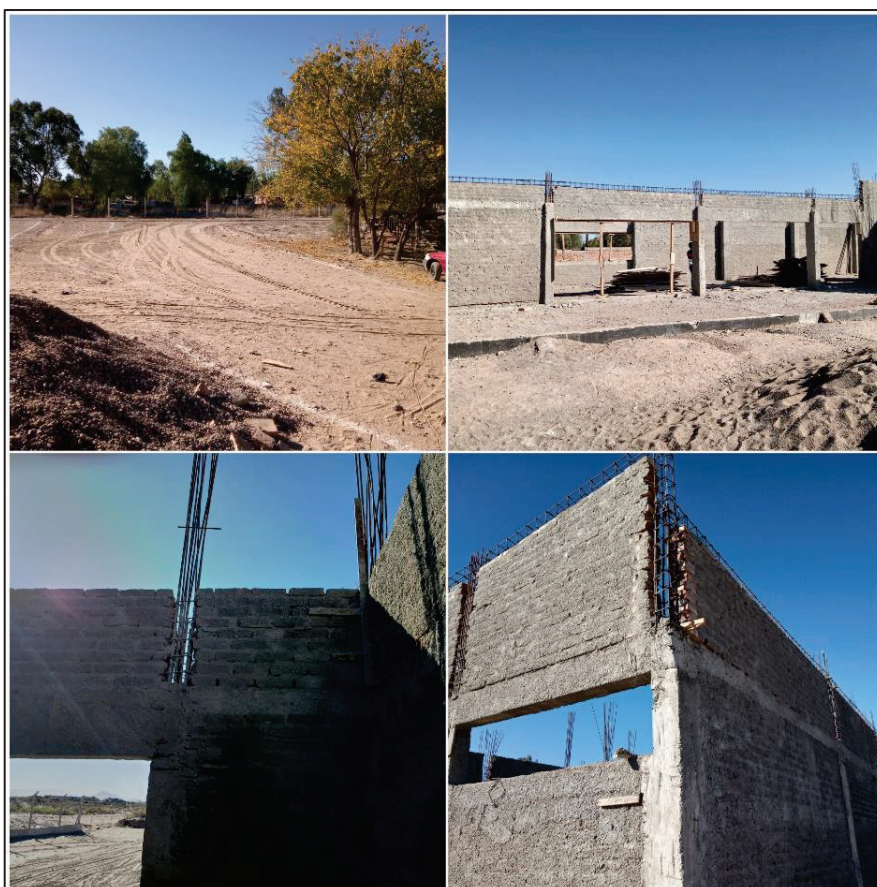
Figura 9: Visita del 3/5/2022 – Avance con los muros y relleno con estabilizado.
