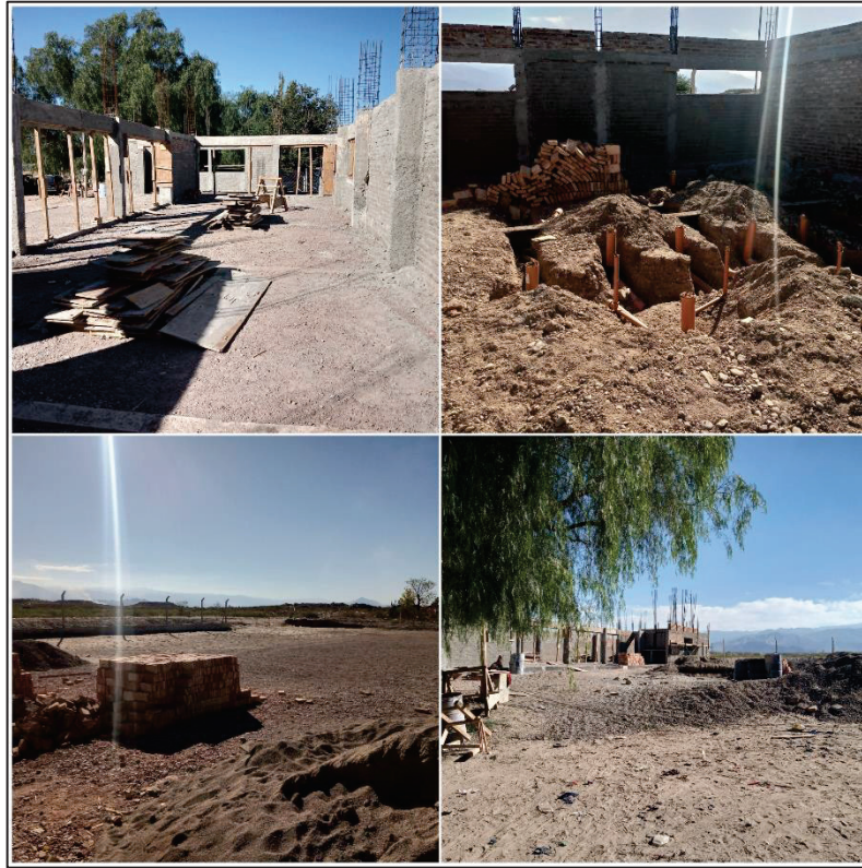
Figura 7: Visita a obra del 18/4/2022 – Primer visita a obra.
