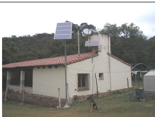
Figura 6: Escuela de La Quebrada – La Viña.
