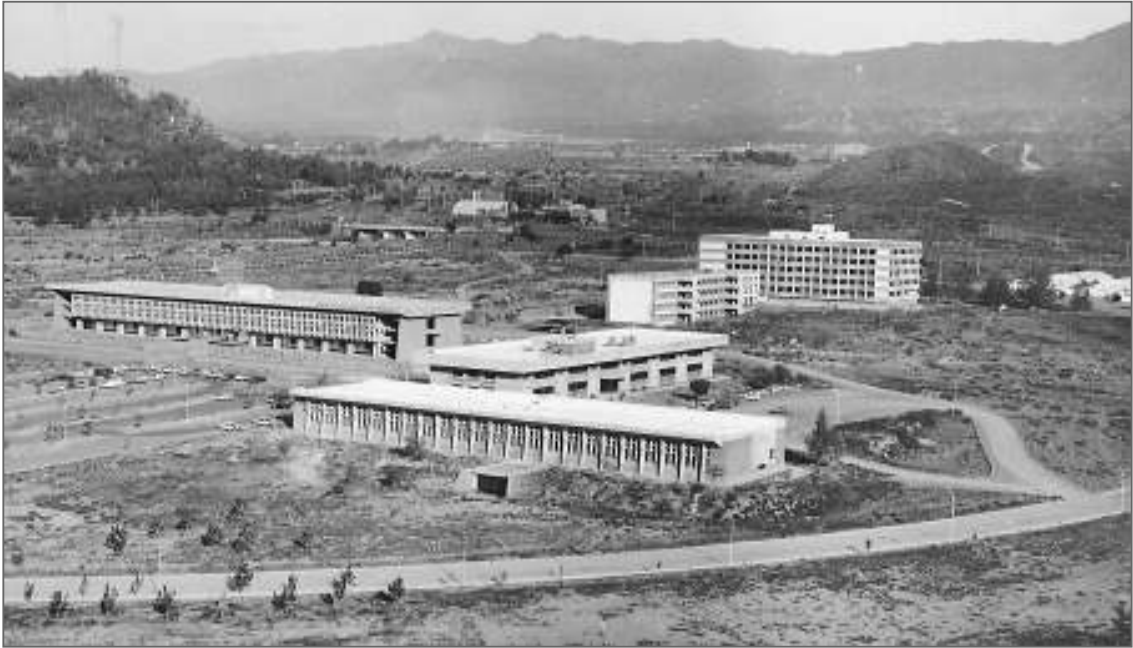
Panorámica aérea hacia el Suroeste.
