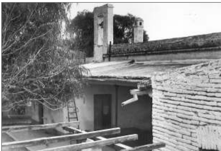
Dependencias del Liceo Agrícola y Enológico cuando es incorporado a la Universidad. Se aprecia el estado precario y de abandono de este sector. Se ubicaba en calle Pedro Molina 450.
