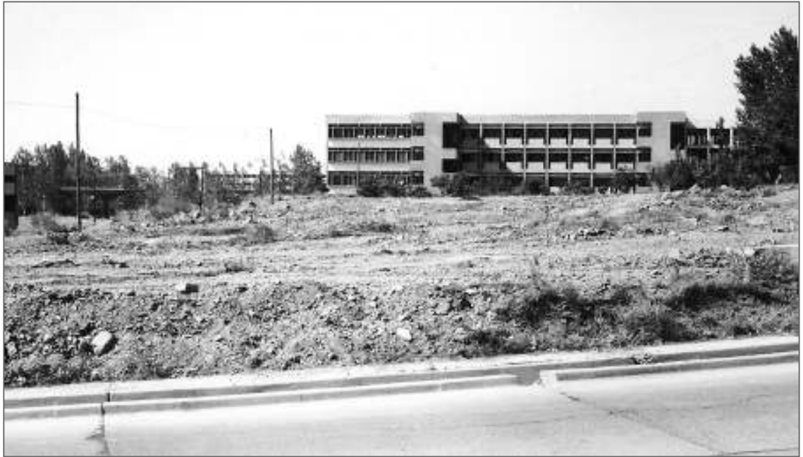
Panorámica hacia el Sur.
