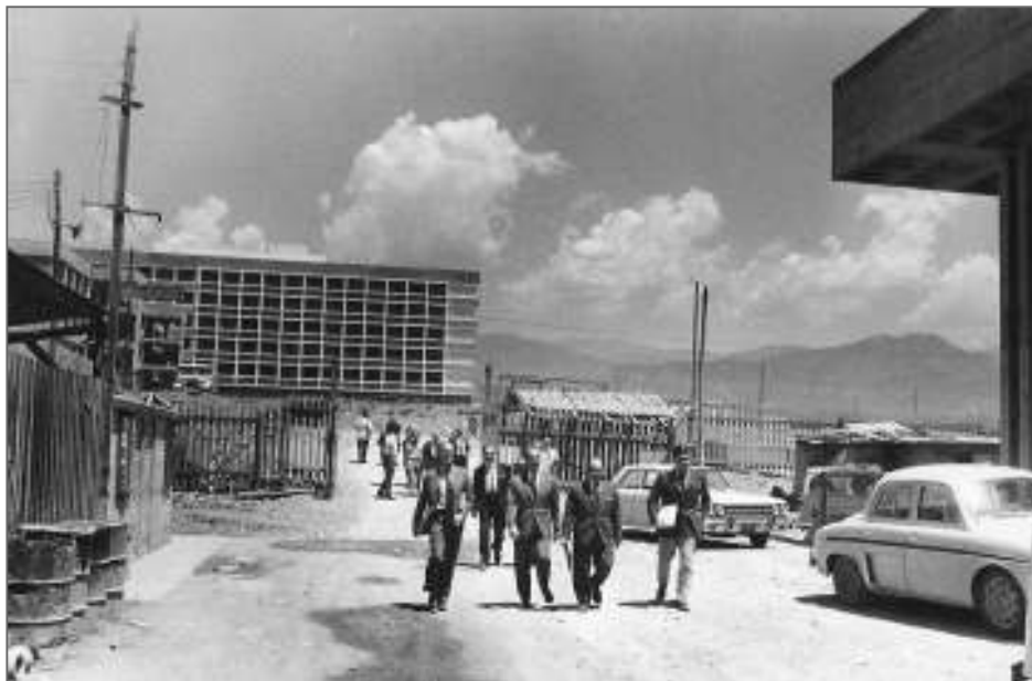
Autoridades de la Universidad recorriendo el sector donde está en terminación el edificio de la Facultad de Ingeniería en Petróleo. Al fondo el volumen de la 1° etapa de la Facultad de Filosofía y Letras, sobre el costado izquierdo la construcción de la 2° etapa. Esta, según consta en el Informe, figura en obras en ejecución en 1969.
