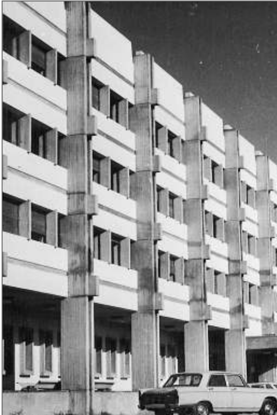
Fachada correspondiente al bloc de la Facultad de Ciencias Económicas.
