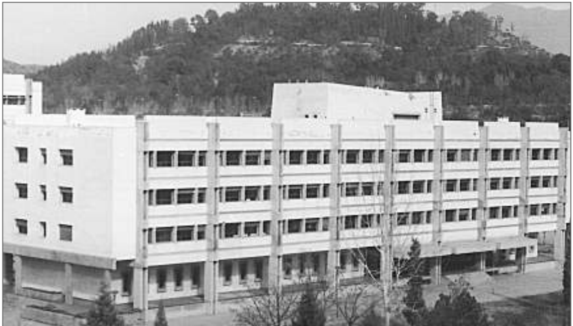
Panorámica hacia el Suroeste.
