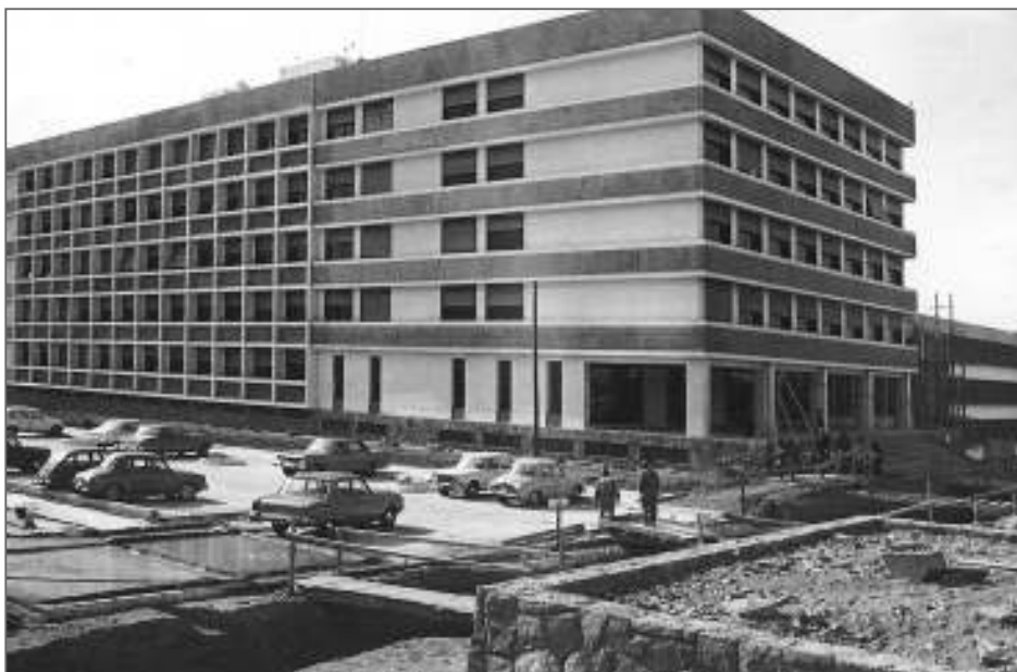
Facultad de Filosofía y Letras (bloc de la 1° etapa) en terminaciones de obra.
