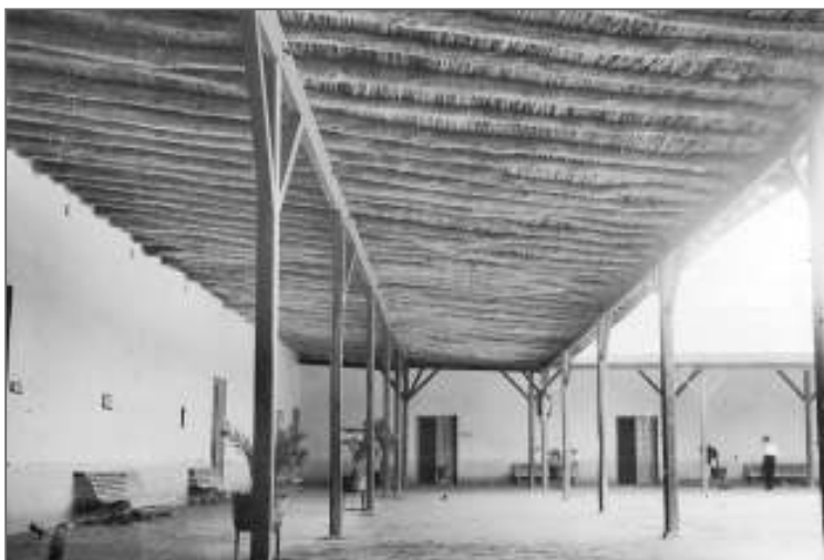
Sector interior del Liceo Agrícola y Enológico, correspondiente a una de las galerías que enmarca un patio. Se observa la estructura de madera (columnas y vigas) y la cubierta a la vista (de rollizos de pino, caña, barro y generalmente terminada con chapa).
