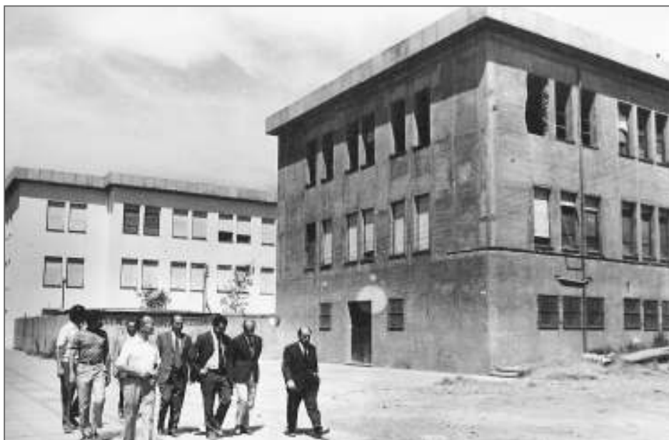
Reacondicionamiento de los Pabellones del ex Hospital de Niños para funcionamiento de la Facultad de Medicina. Se observa terminado el del fondo y en proceso el de primer plano, en ambos casos ya se han reemplazado las cubiertas a dos aguas por techo plano (año 1971). Si bien es una foto posterior, la incorporo como muestra del estado edilicio de los pabellones (por abandono) al pasar a la Universidad. En la foto el Rector Julio Herrera y el Arq. Aniceto Puig, de recorrida.
