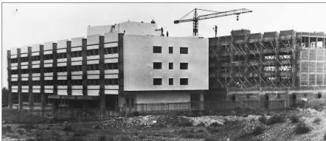
Vista de la construcción del bloc correspondiente a la 2º etapa de la Facultad de Ciencias Económicas. Según consta en el Informe del Rectorado. Octubre 1967 - Junio 1969, figura en obras en ejecución en 1969. En el Informe consta que el 1º bloc de la izquierda figura en etapa de terminaciones en 1969.
