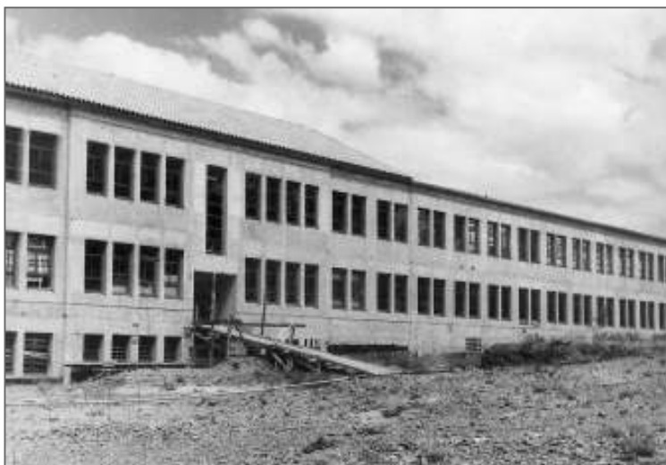
Reacondicionamiento de un pabellón de la construcción perteneciente al Hospital de Niños, iniciado por la Fundación Eva Perón y posteriormente cedido a la Universidad con el predio. Según consta en el Informe del Rectorado. Octubre 1967 - Junio 1969, en obras terminadas en 1968 figura: Habilitación en Facultad de Ciencias Medicas de sectores (terminación de frente parcial).
