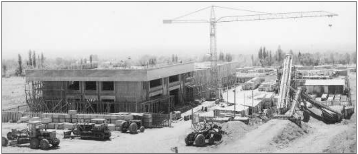
Construcción de la Facultad de Ingeniería en Petróleo. Según consta en el Informe del Rectorado. Octubre 1967 - Junio 1969 figura en obras en ejecución en 1969.
